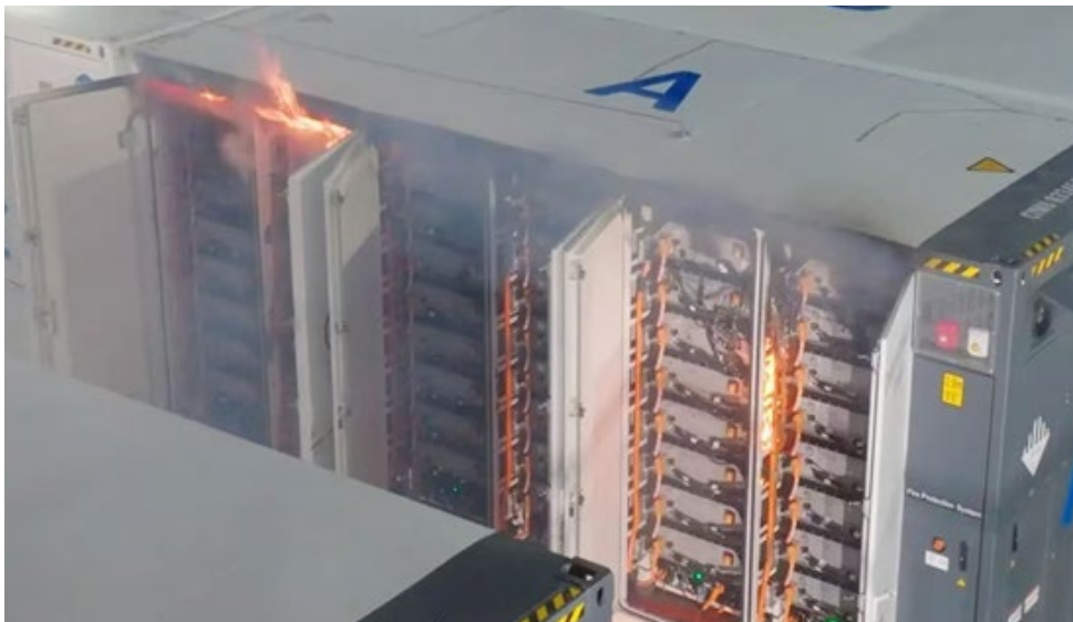
Fire Test Site
